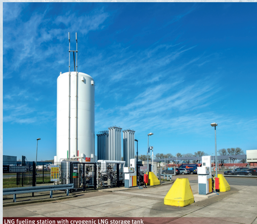
LNG fueling station with cryogenic LNG storage tank
